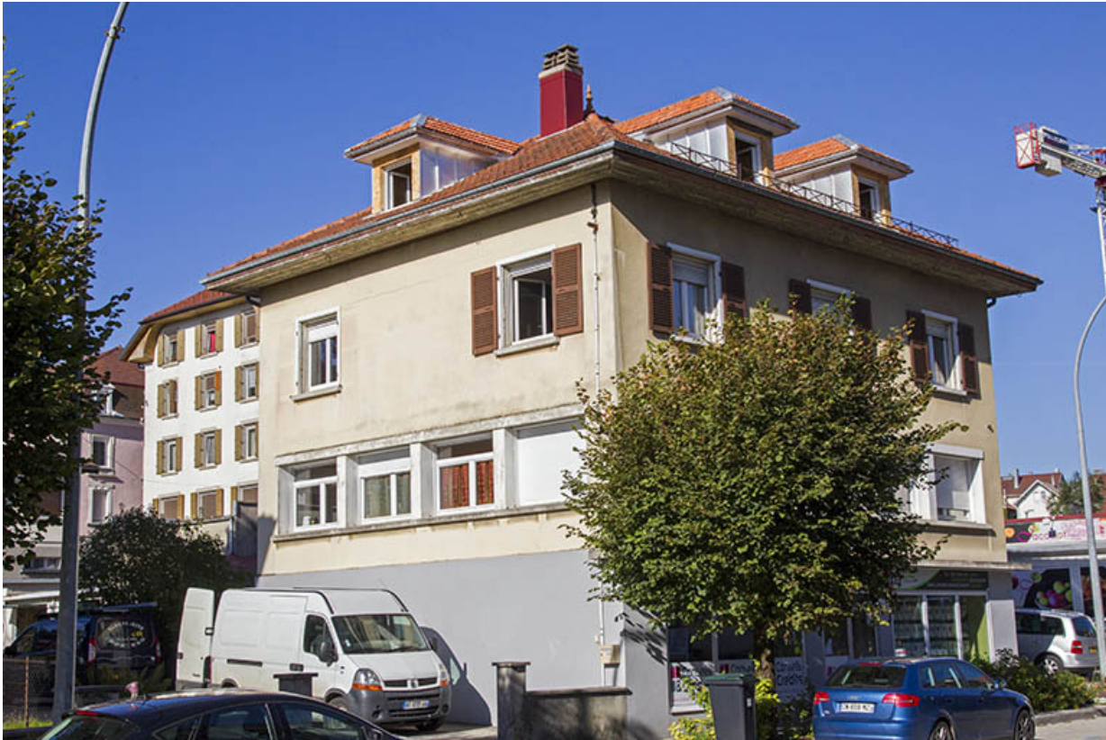
Façades antérieure et latérale gauche.
