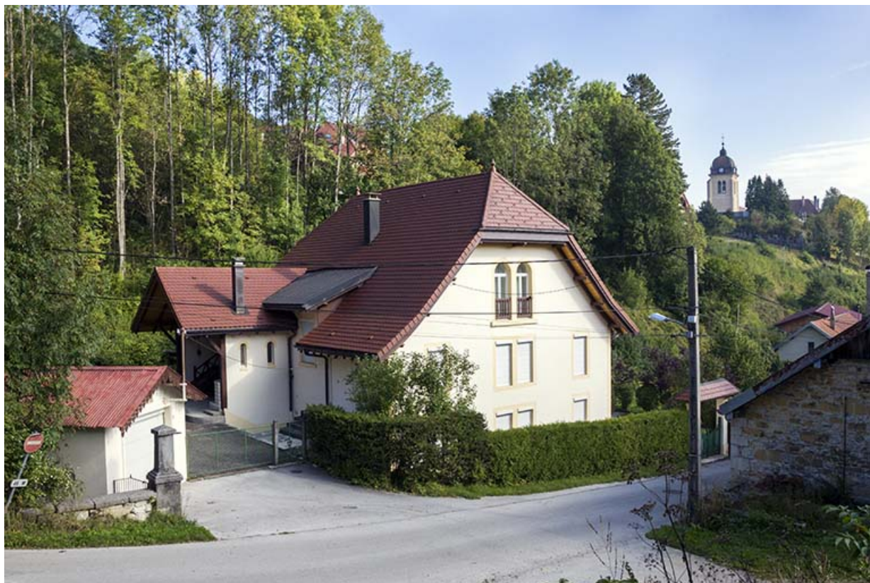
Logement patronal (ancienne ferme), vu du sud-ouest.
