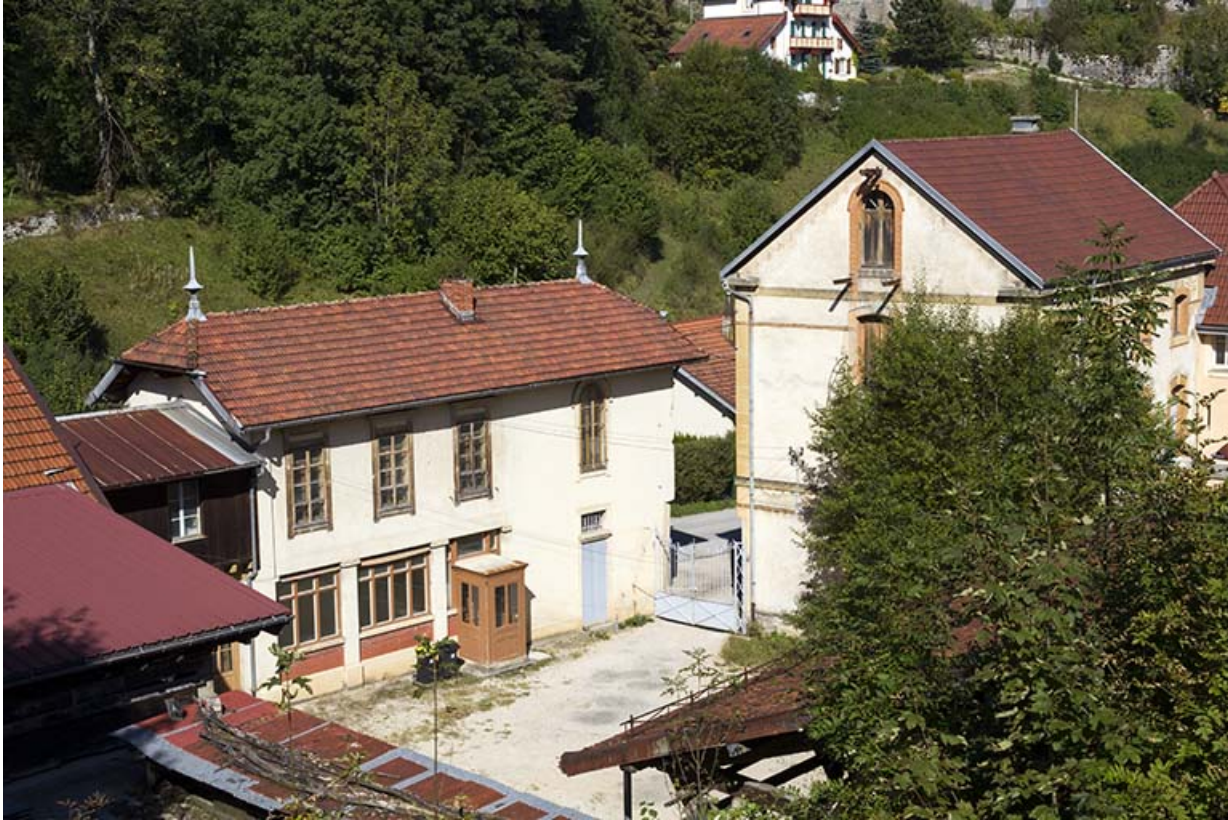
Bureau et laboratoire : façade sur cour.
