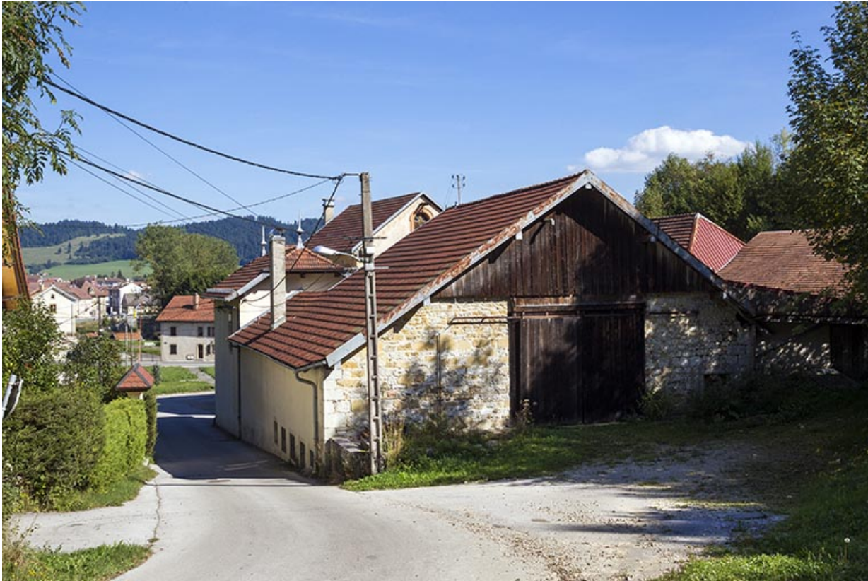
Bureau, écurie et grange, depuis l'ouest.
