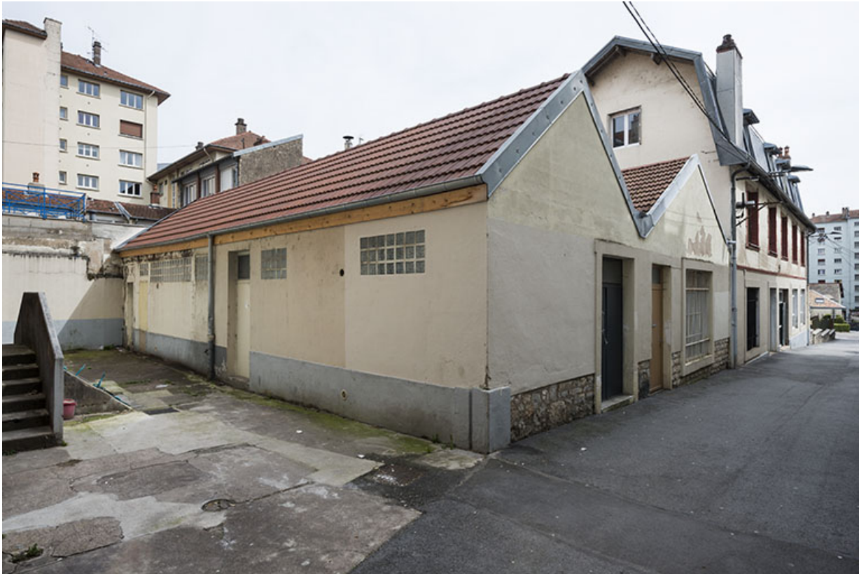
Vue depuis le nord de l'impasse Rambaud.
