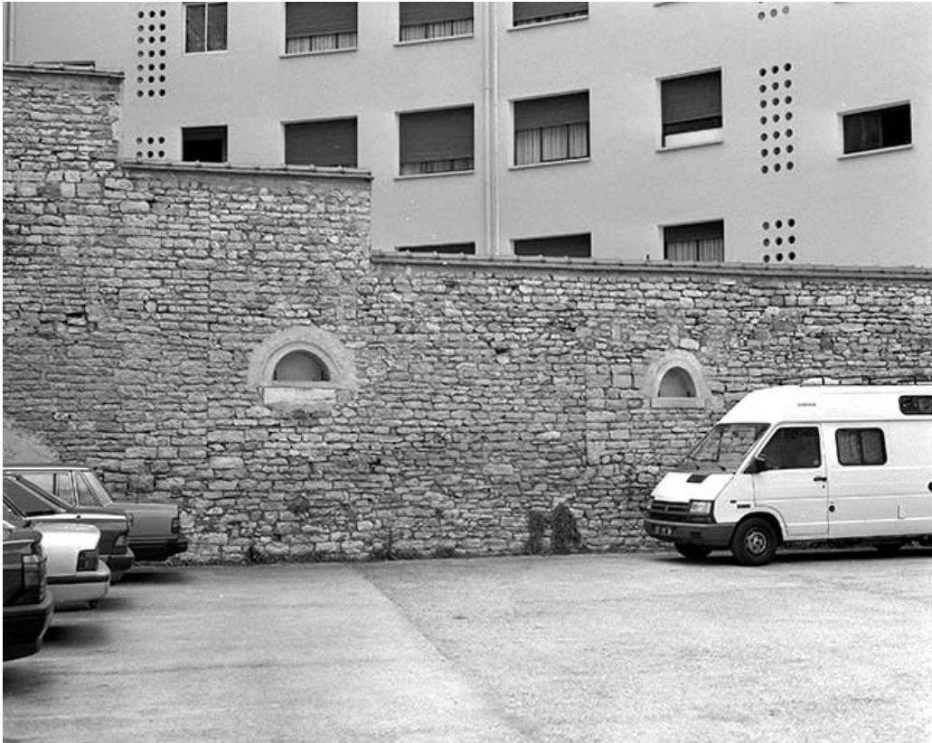
Cour : détail du mur de clôture droit.
