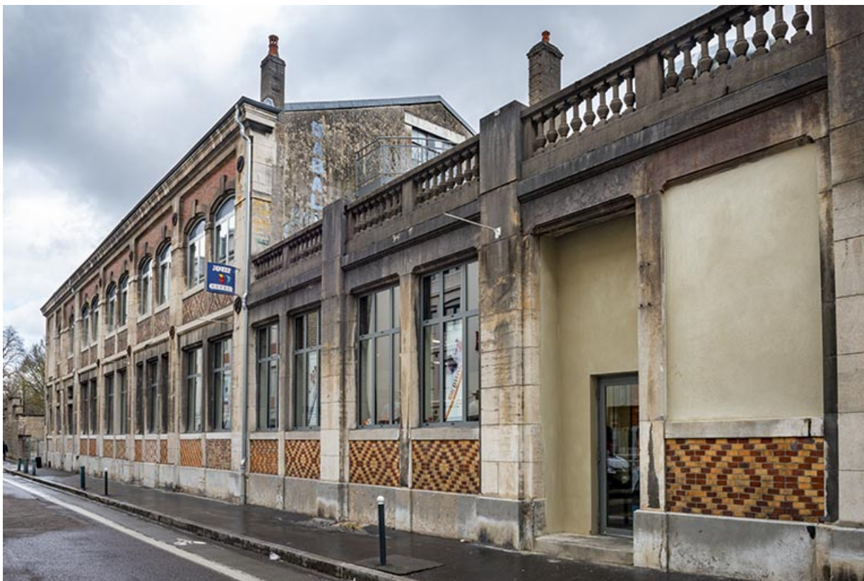
Vue rapprochée depuis le sud-ouest (après travaux).
