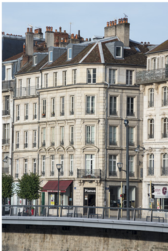
Vue éloignée depuis l'est.
