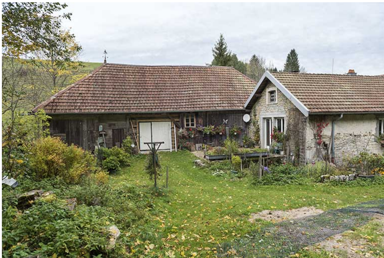
Scierie : façade est.
