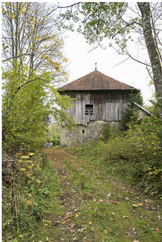
Scierie : façade sud.
