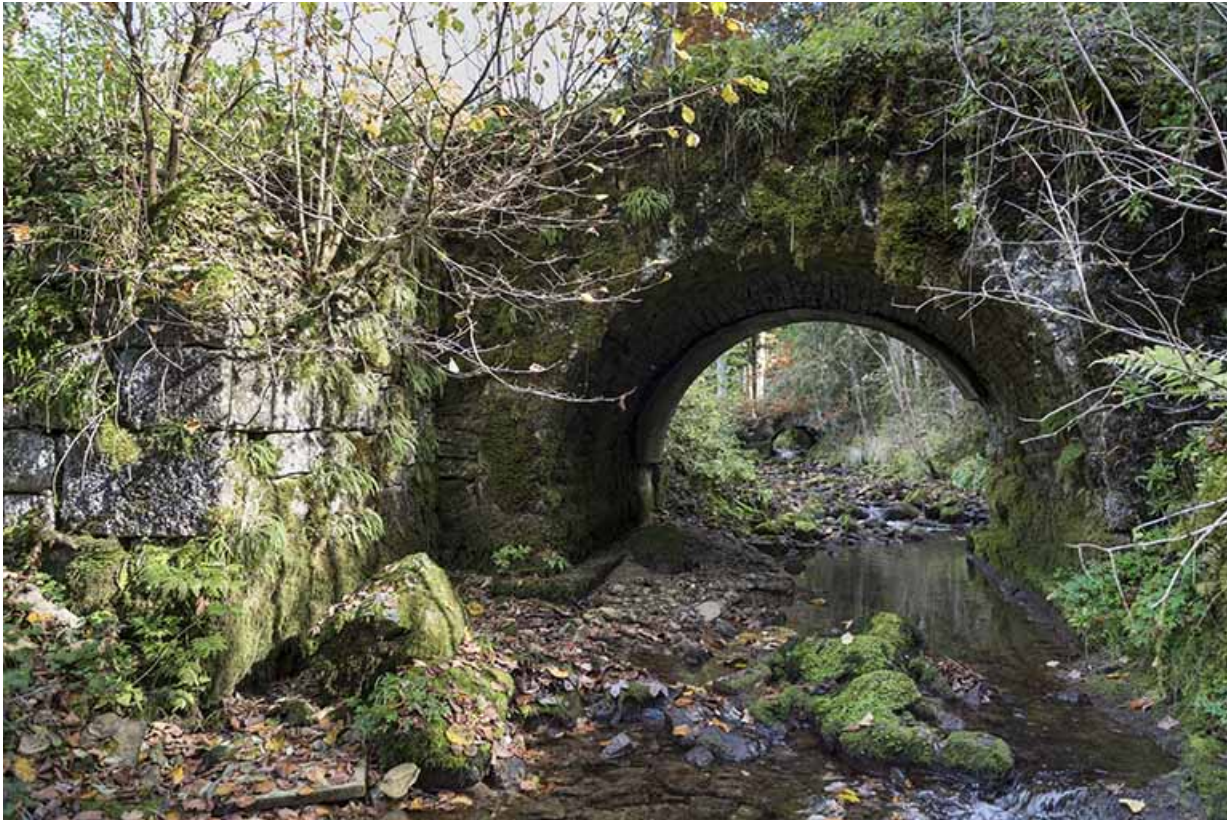
Pont en aval, à l'ouest.
