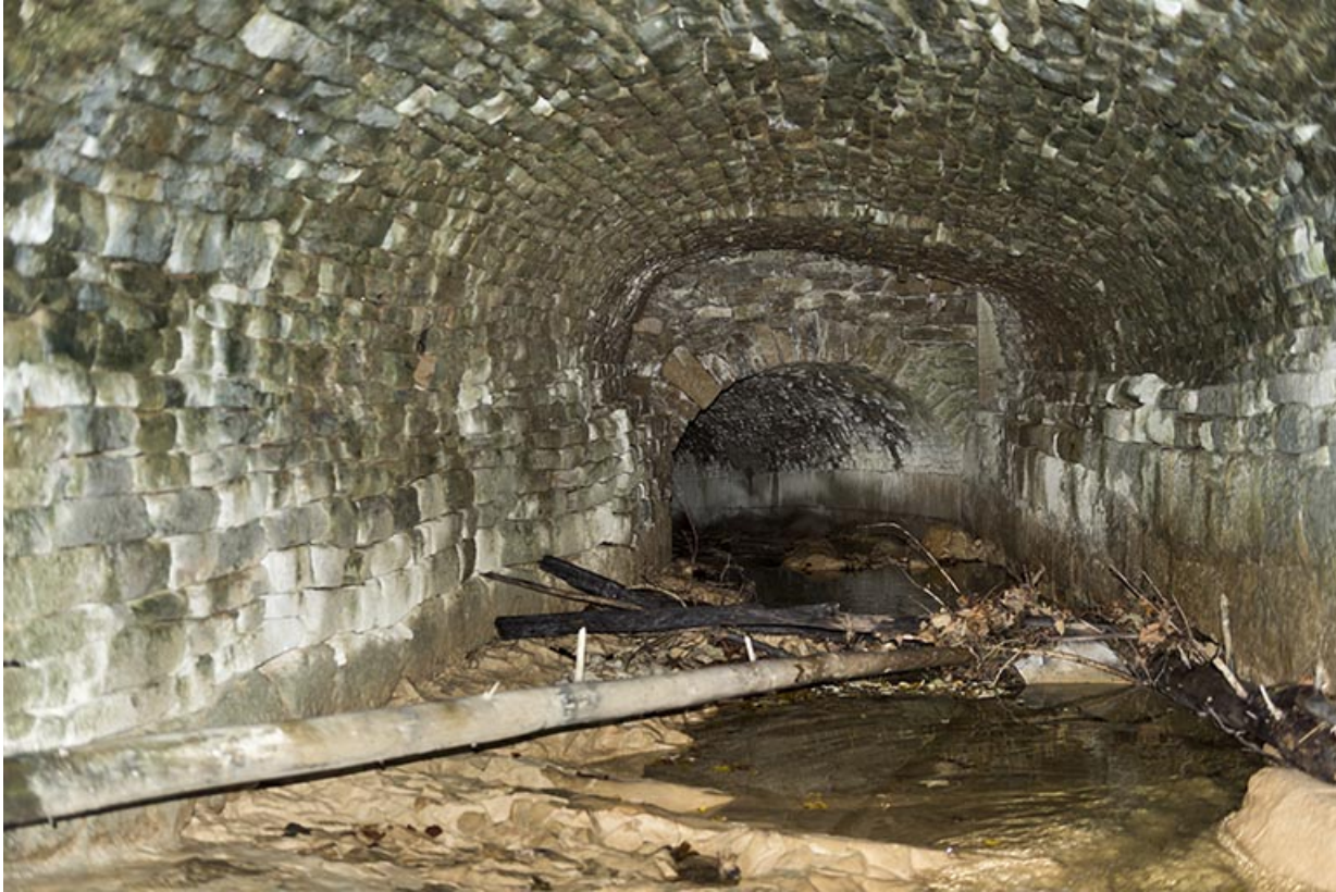
Voûte sur le ruisseau couvert.
