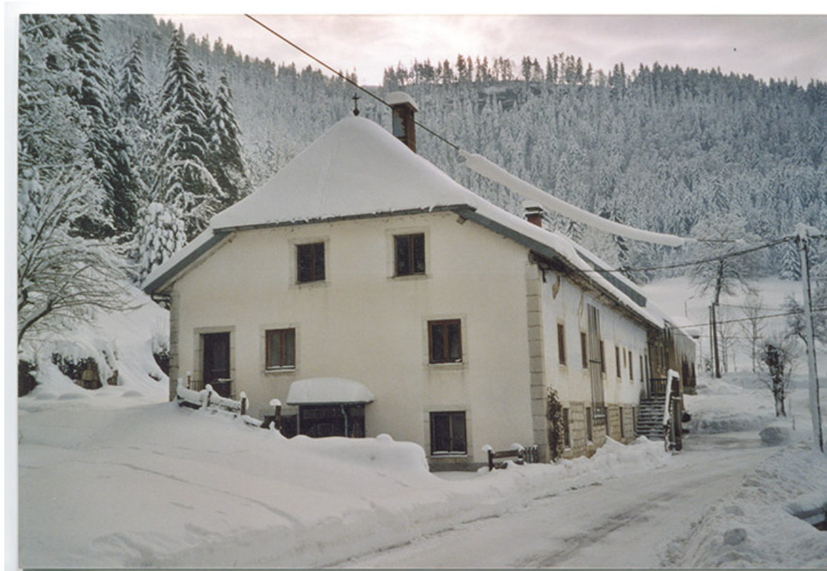
[L'usine Sauge sous la neige en mars 2003].
