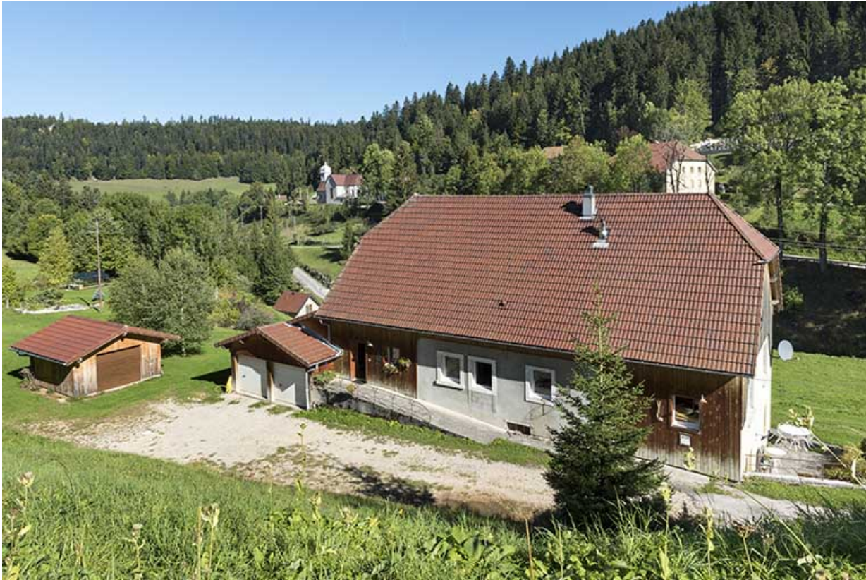
Vue plongeante sur la façade sud.
