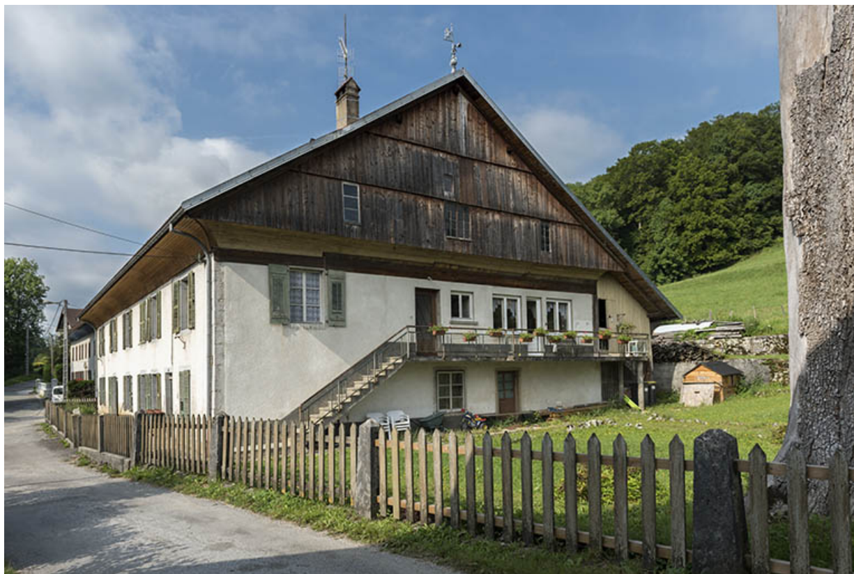
Façade latérale droite, de trois quarts gauche.
