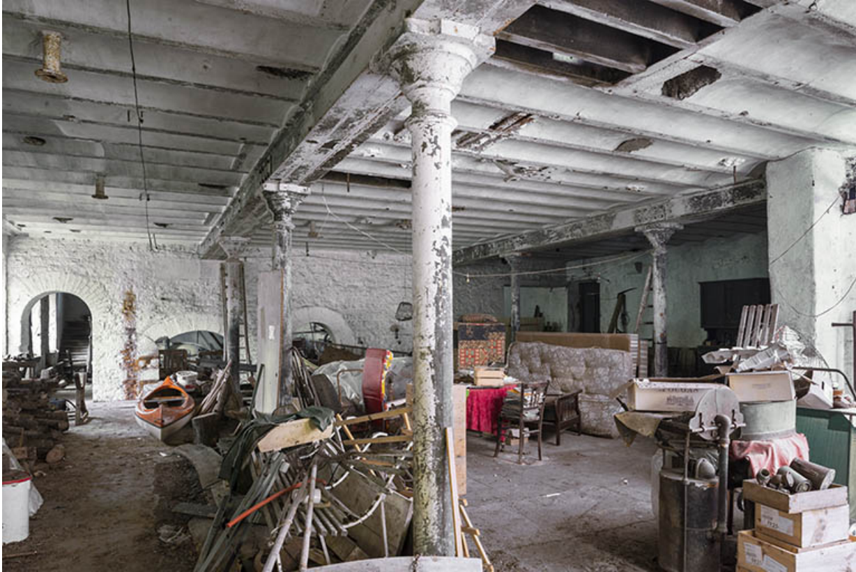
Atelier de fabrication. Vue du rez-de-chaussée.
