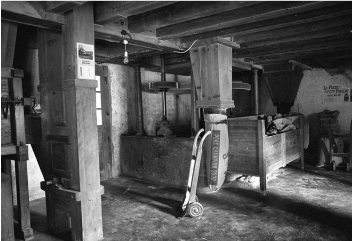
Vue intérieure : chargement des sacs.
