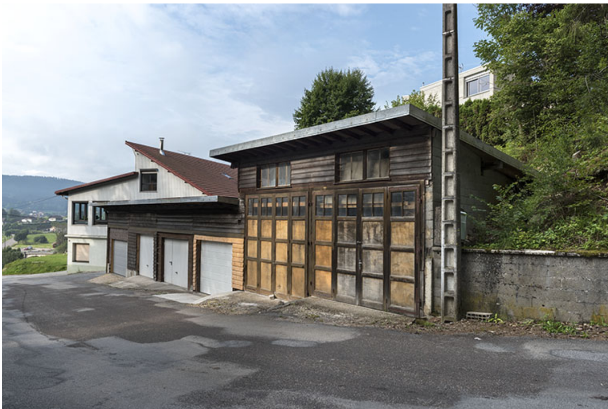
Garages, depuis le nord-est.
