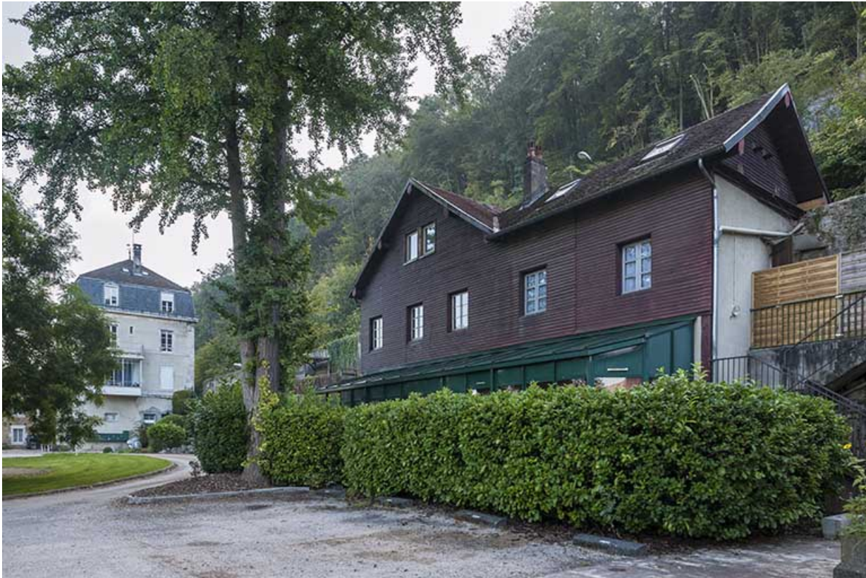
Logement patronal et logement (remanié).
