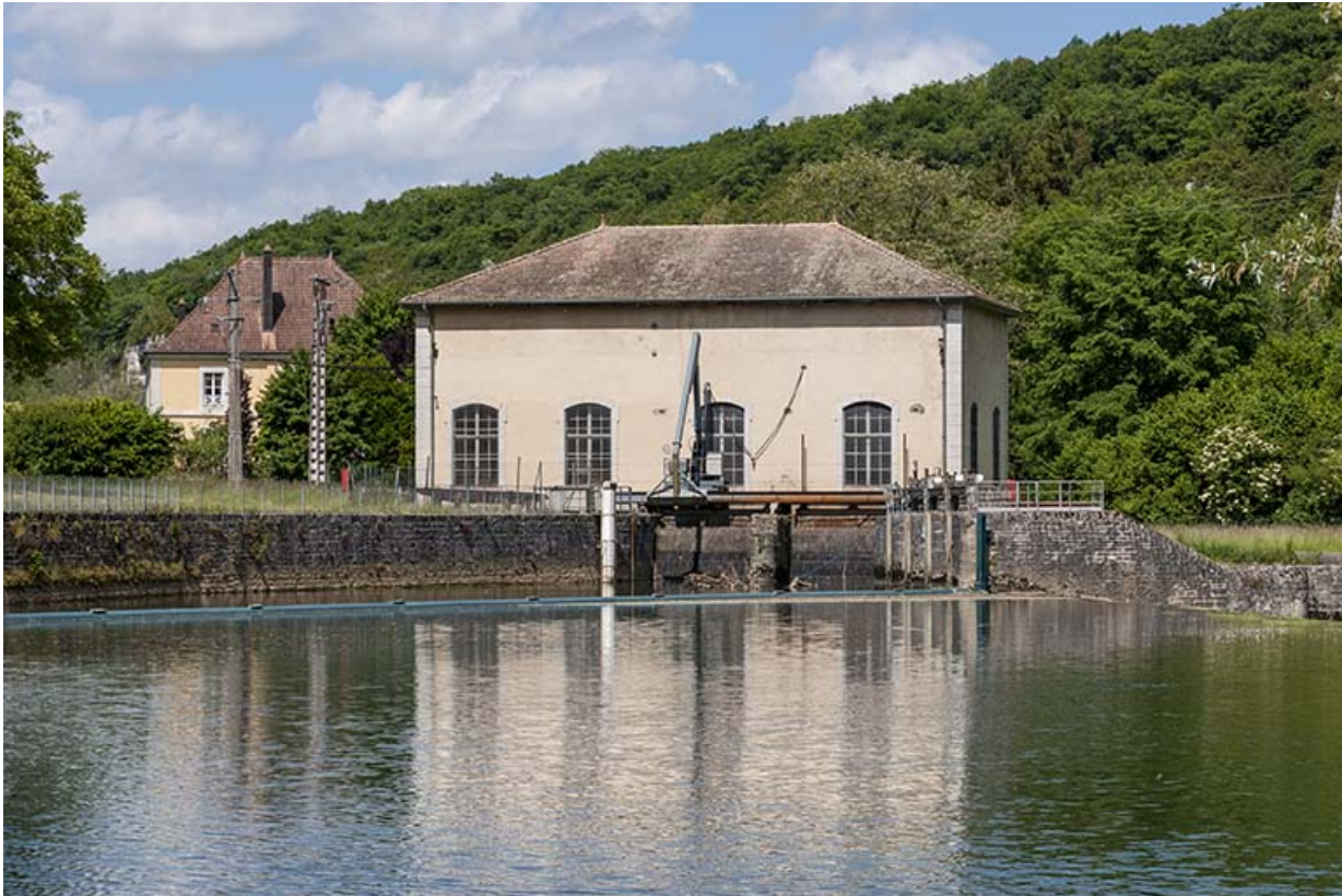
La centrale hydroélectrique vue depuis l'est.
