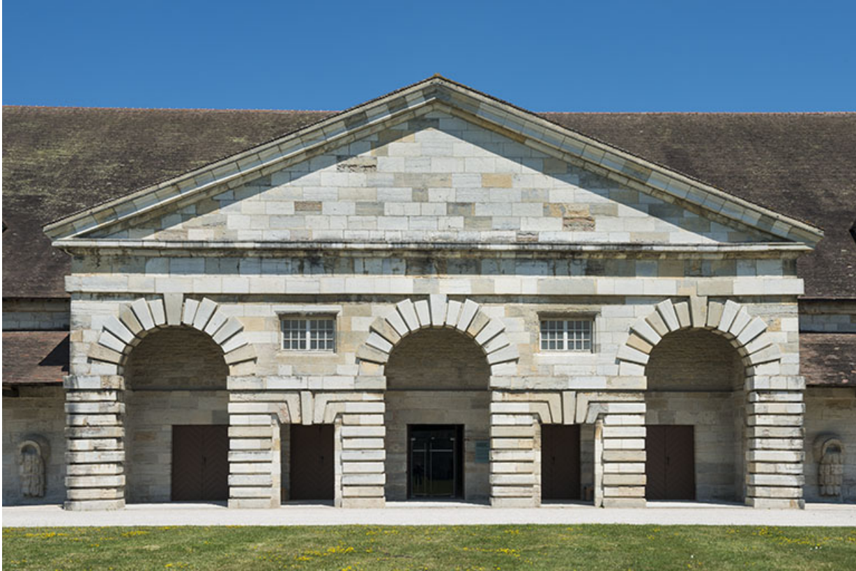
Berne est. Détail du portique.
