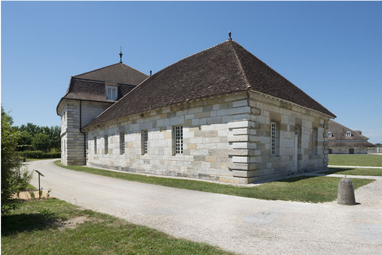
Tonnellerie vue de trois quarts arrière.
