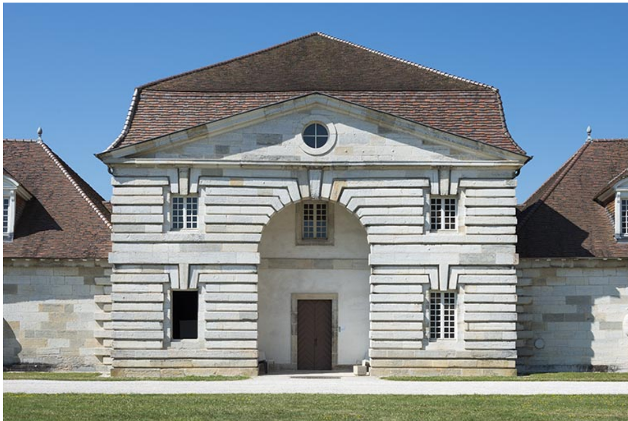
Logement des ouvriers ouest. Pavillon central.
