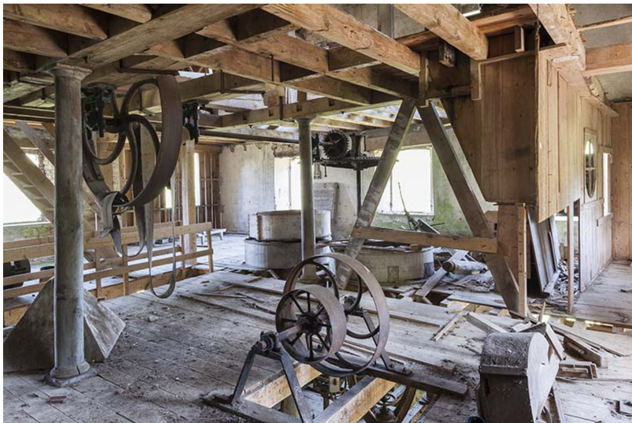
Premier étage. Vue d'ensemble depuis le sud-est.
