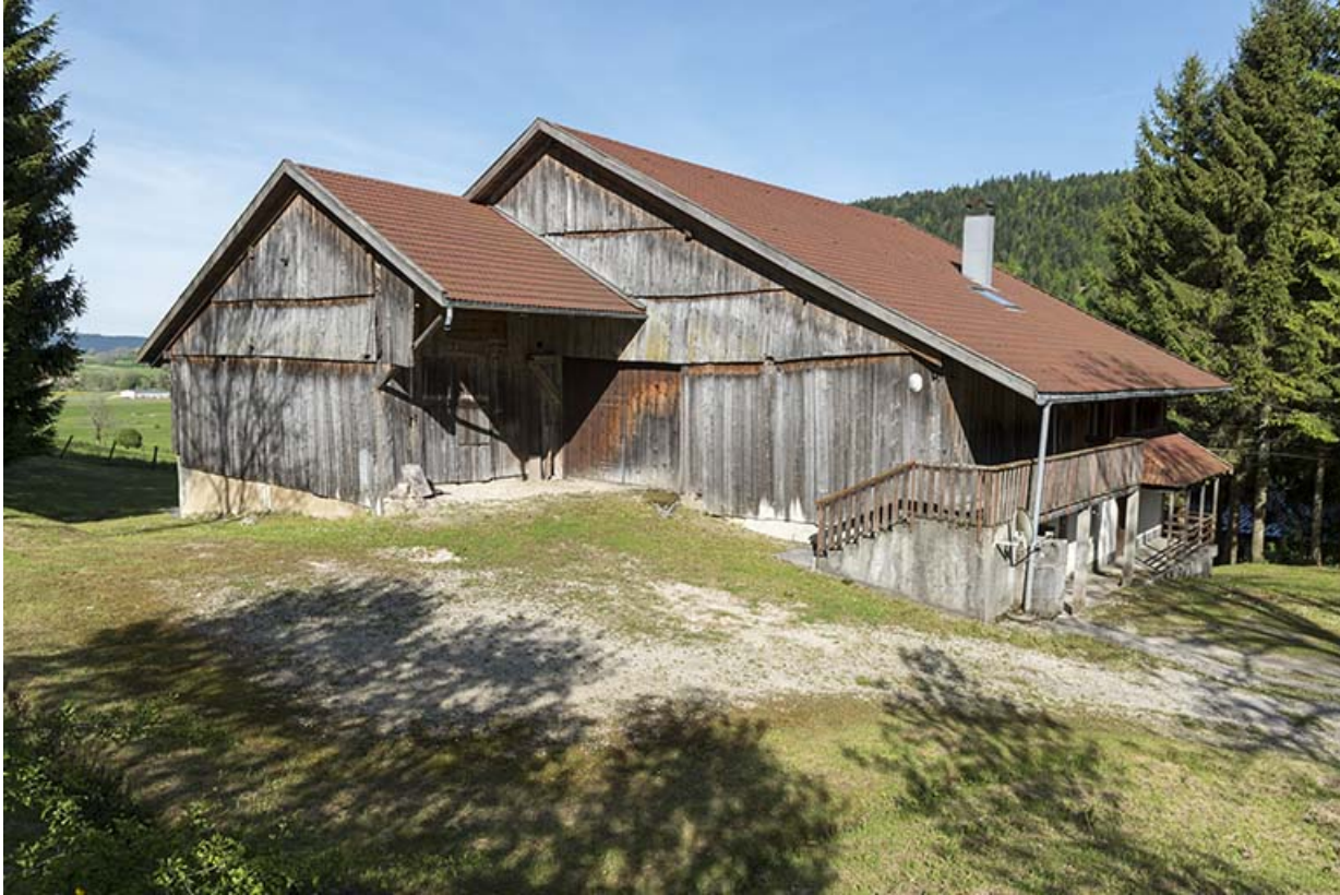
Façades postérieure et latérale gauche.
