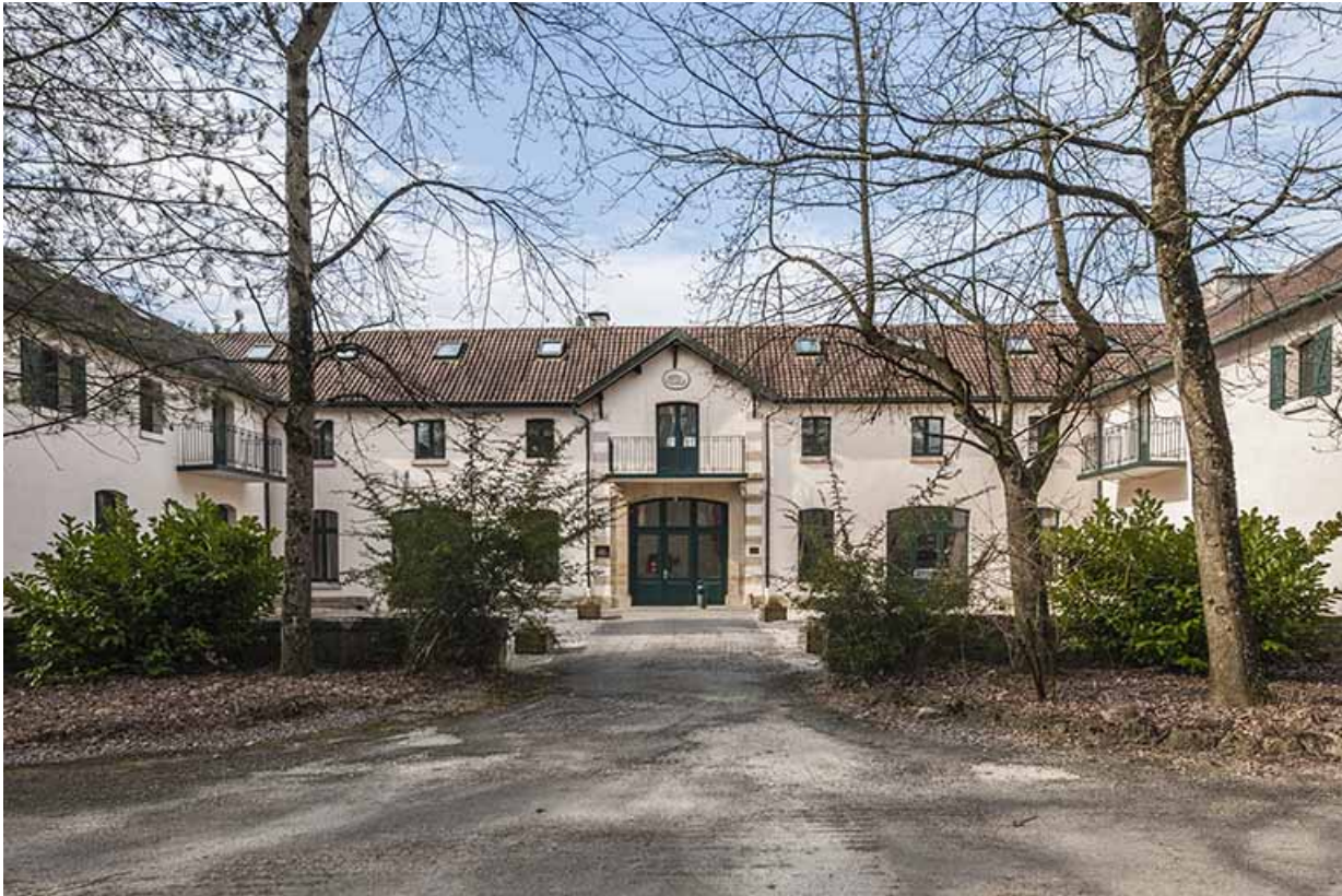
Bâtiment des communs. Vue axiale.
