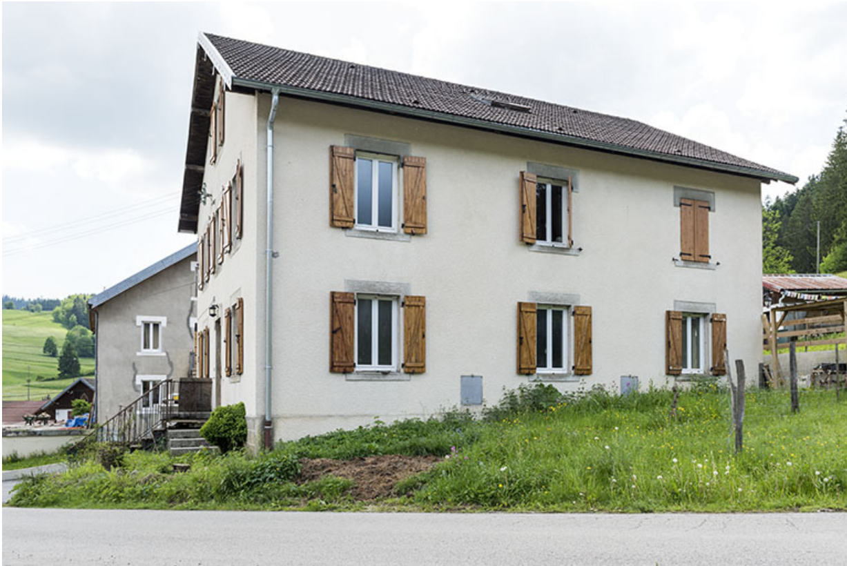
Façade latérale droite.
