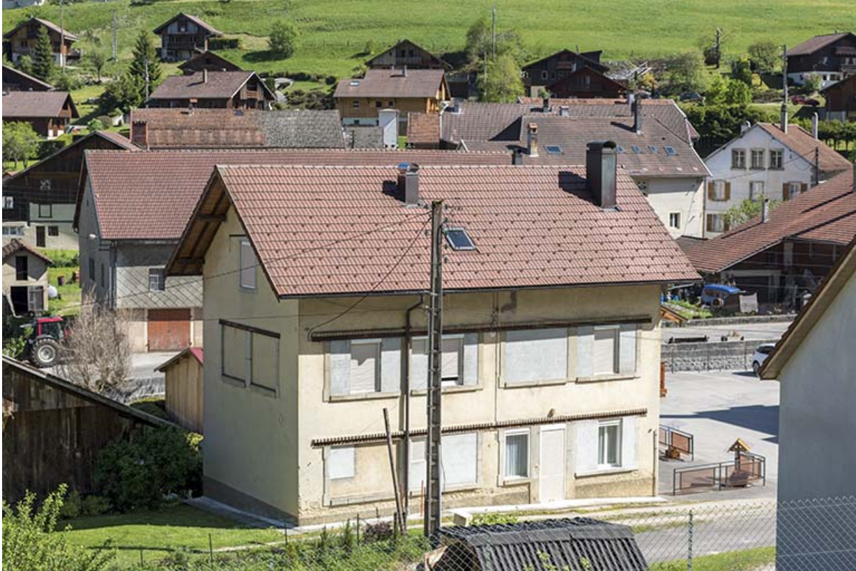
Façades postérieure et latérale gauche.
