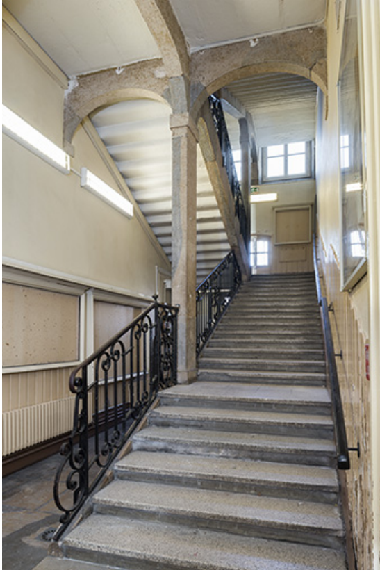
Grand escalier : vue d'ensemble au rez-de chaussée.
