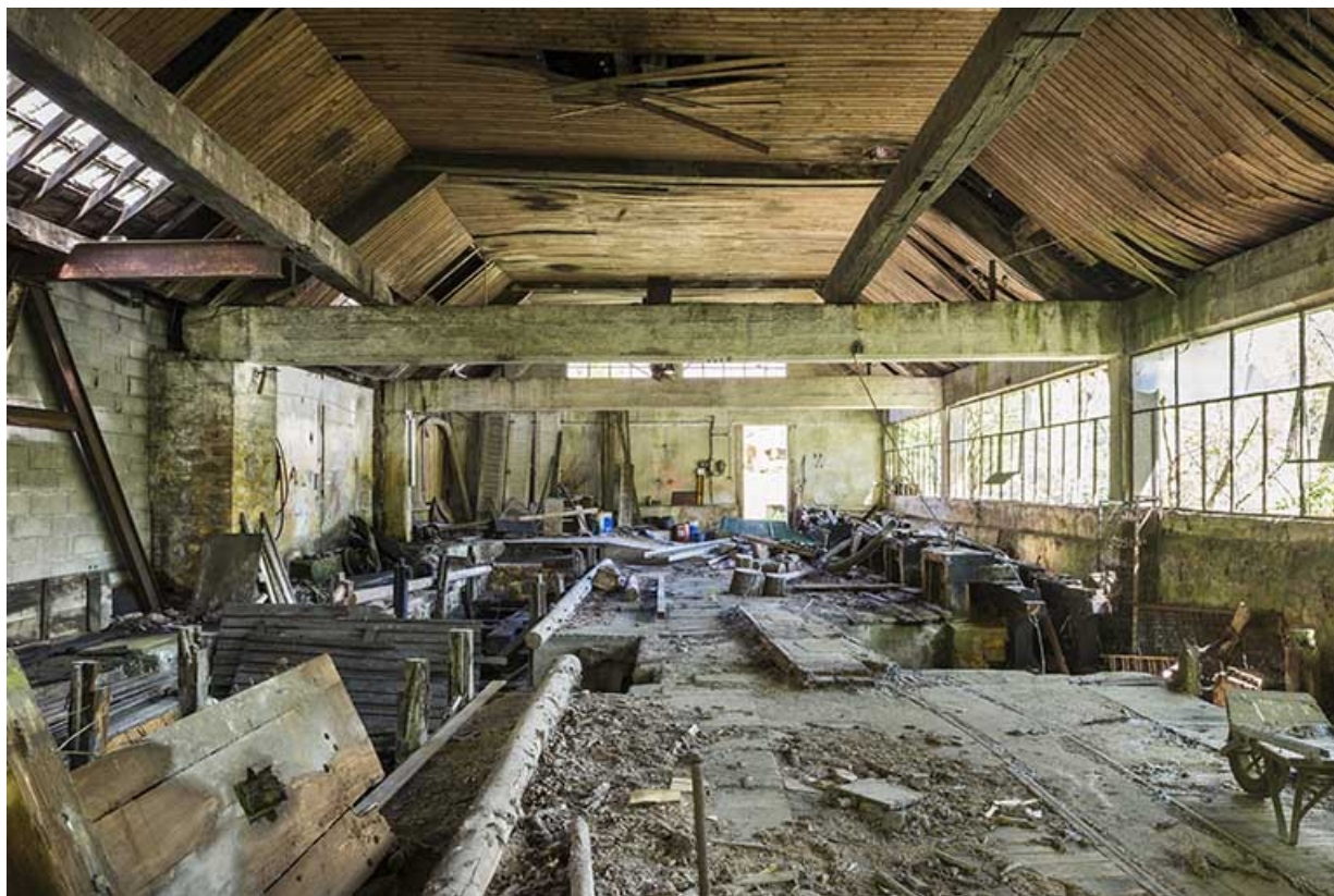
Atelier de tréfilerie. Extrémité est.
