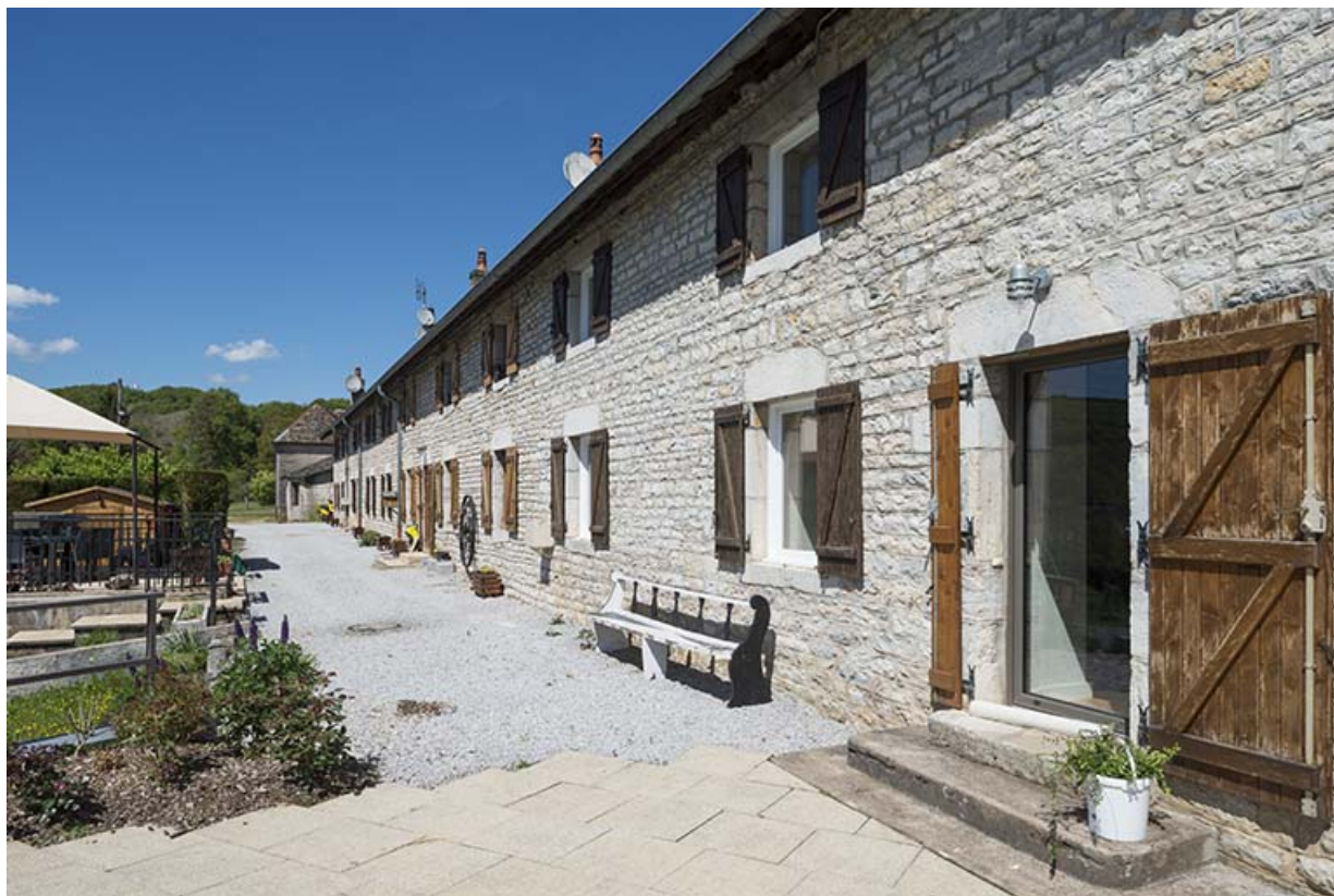
Logement ouvrier. Façade antérieure de l'aile sud.
