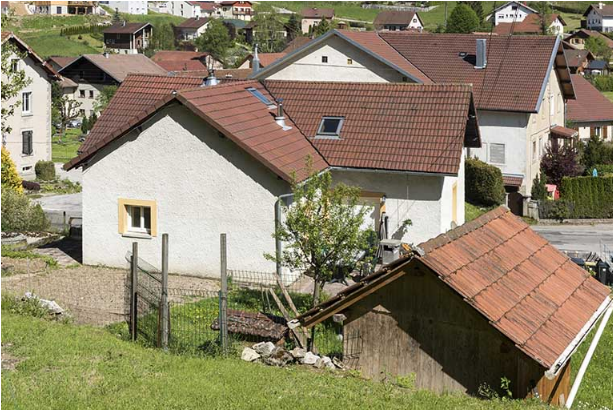
Façade postérieure (vue plongeante).
