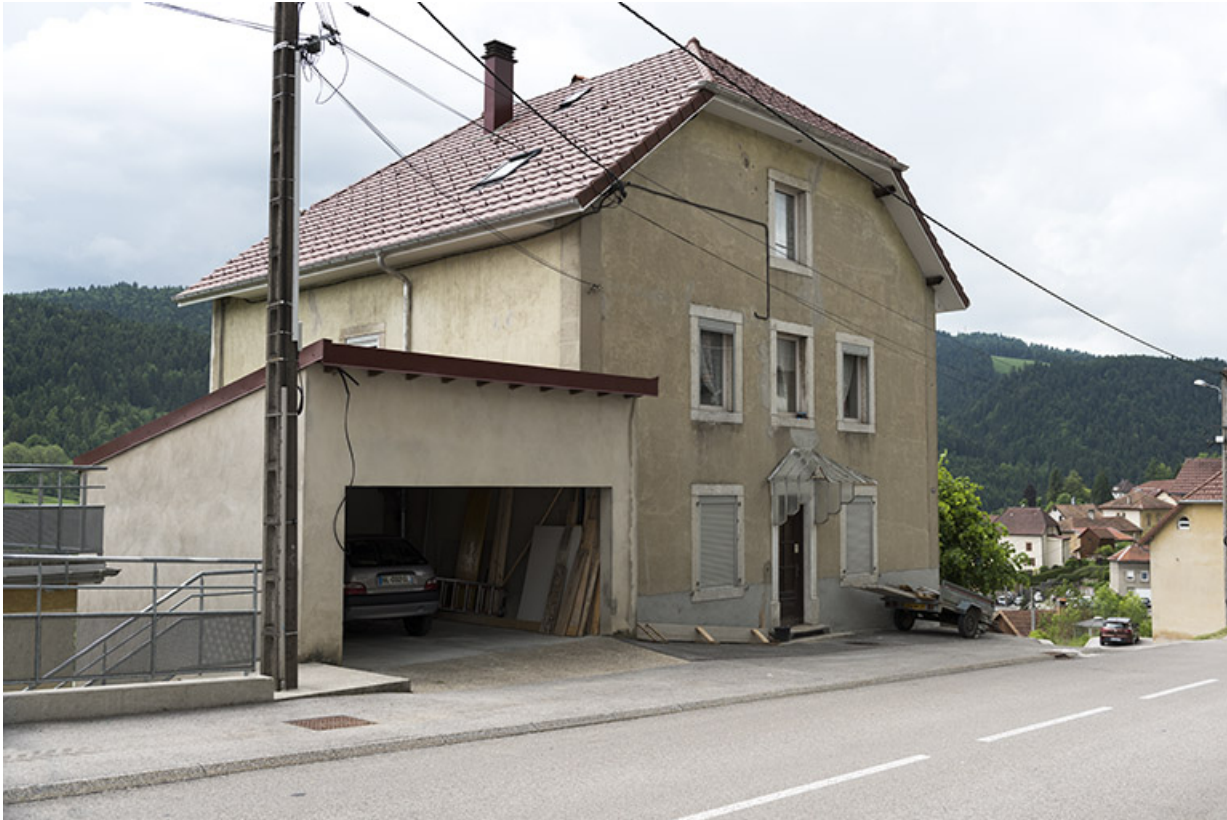
Façades antérieure et latérale gauche.
