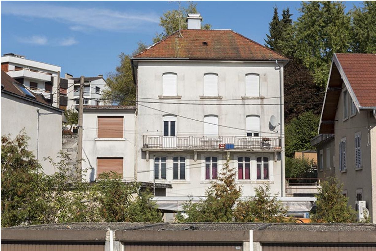
Maison : façade antérieure.
