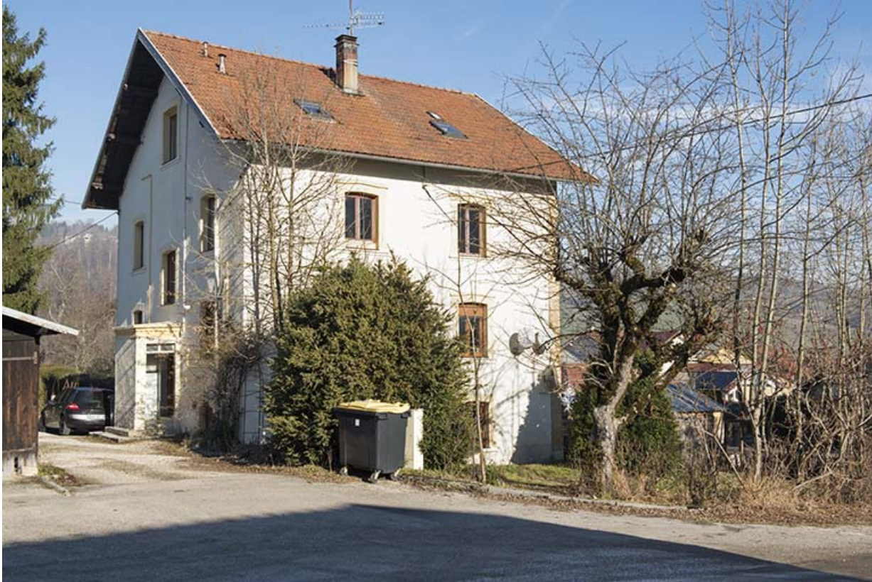
Façades postérieure et latérale gauche.
