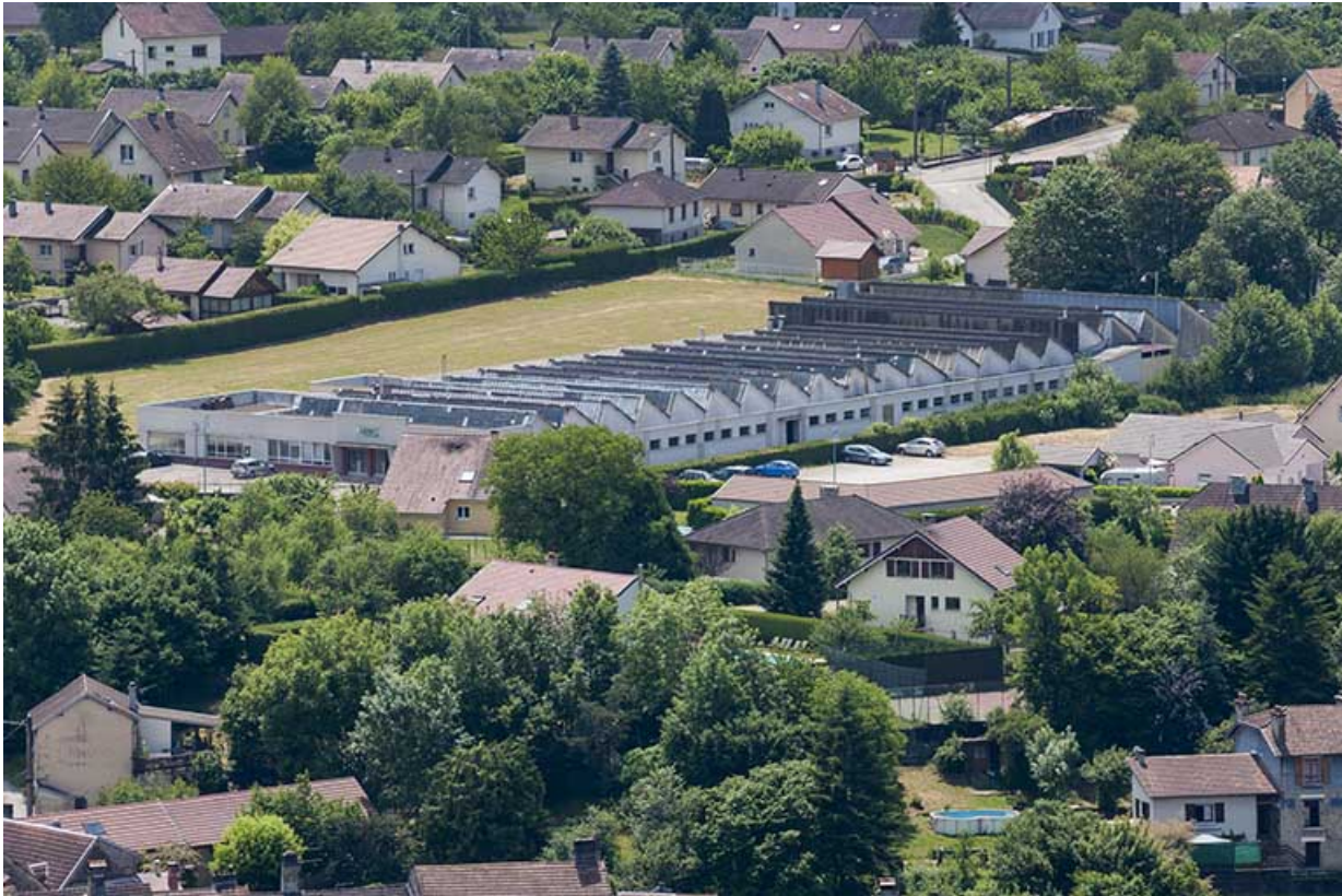
Vue plongeante depuis le nord-ouest.
