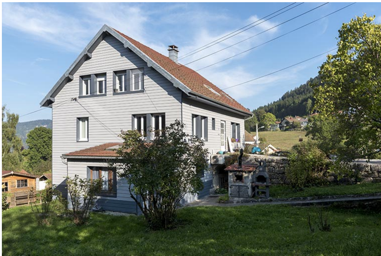
Façades antérieure et latérale gauche.
