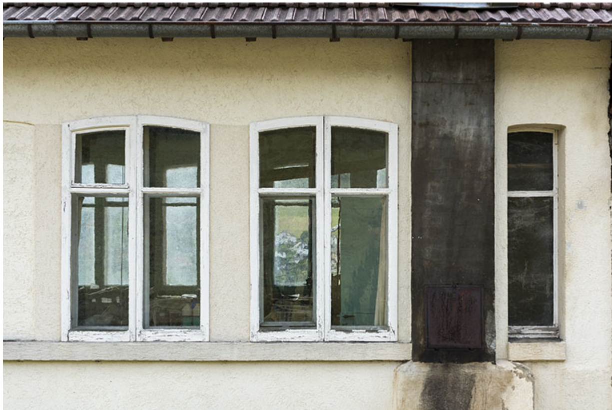
Atelier de fabrication : fenêtre horlogère au nord.
