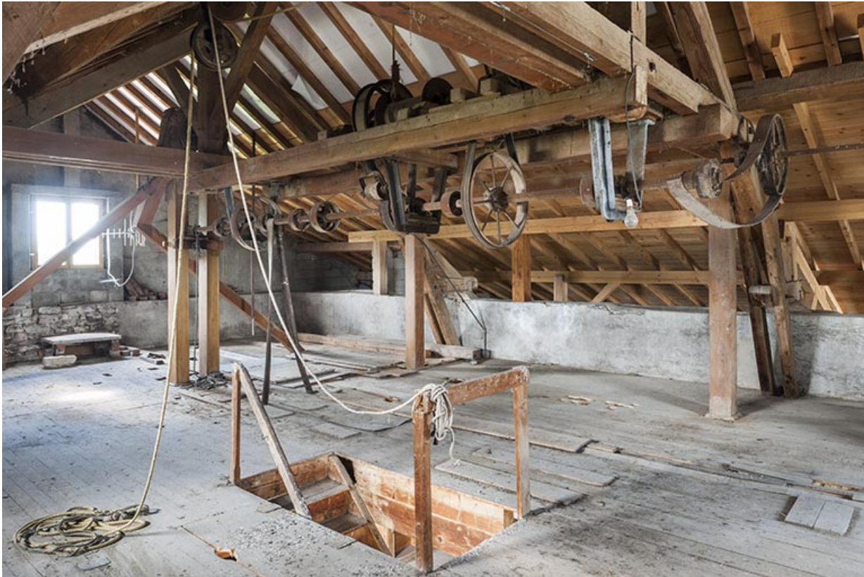
Etage en surcroît. Vue d'ensemble.
