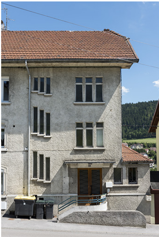
Façade antérieure : partie droite.
