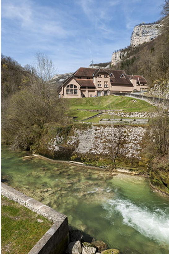
Le bâtiment d'exploitation depuis le sud.
