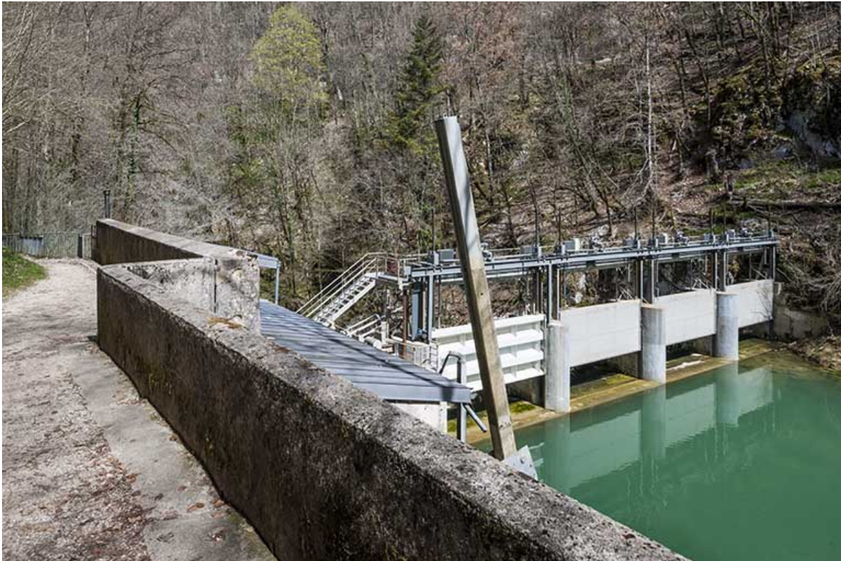
Barrage du bassin de retenue.
