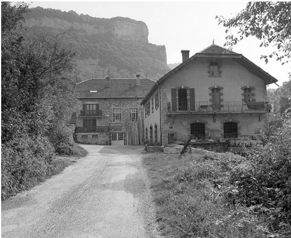
Vue rapprochée depuis l'ouest..
