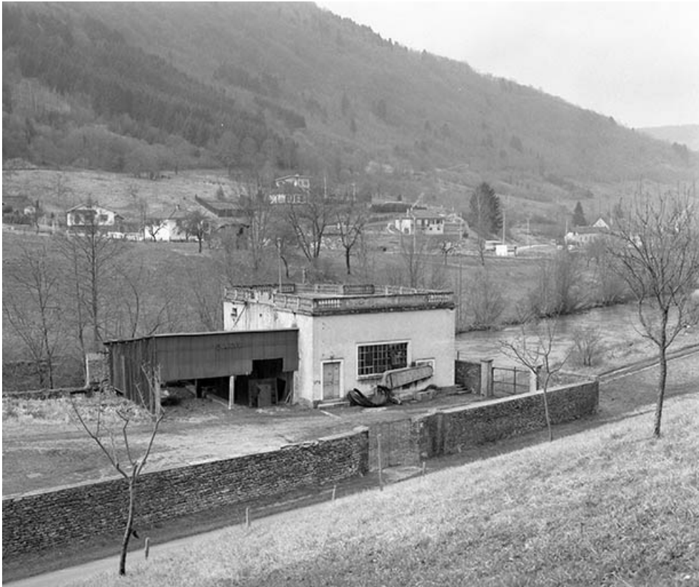
Le bâtiment d'eau de la tréfilerie Bersaillin.
