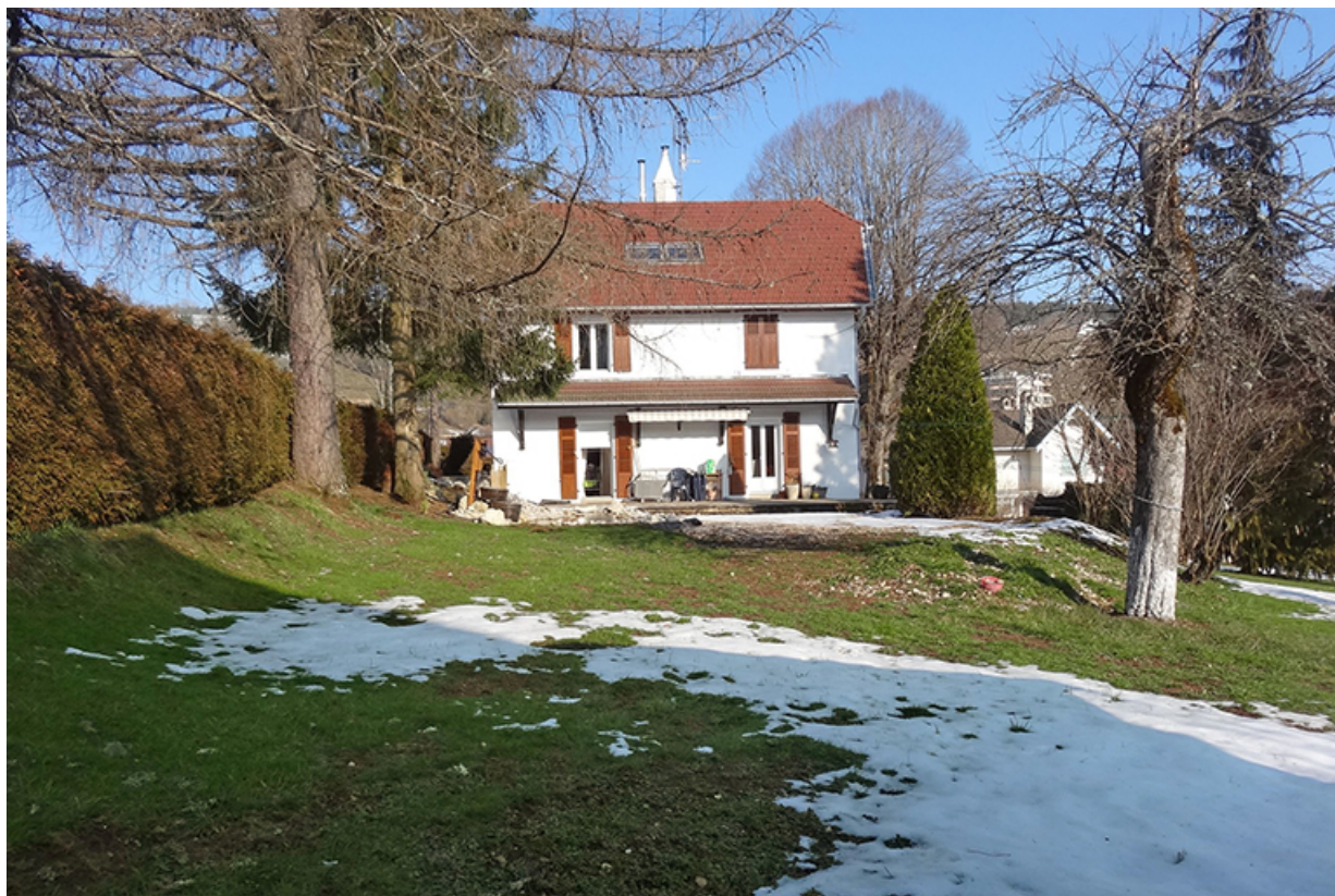
[Façade postérieure de la maison, 14 mars 2013].
