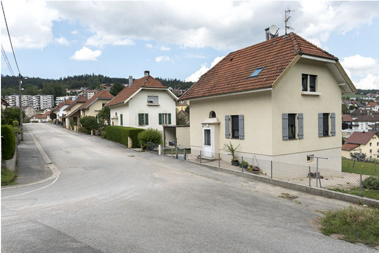
Façades antérieure et latérale droite.
