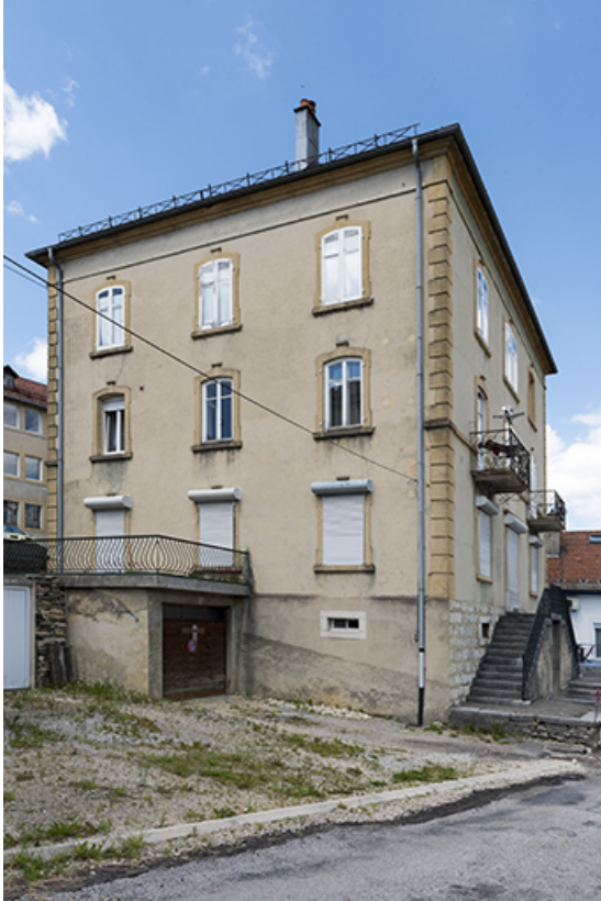
Façade latérale gauche, de trois quarts.
