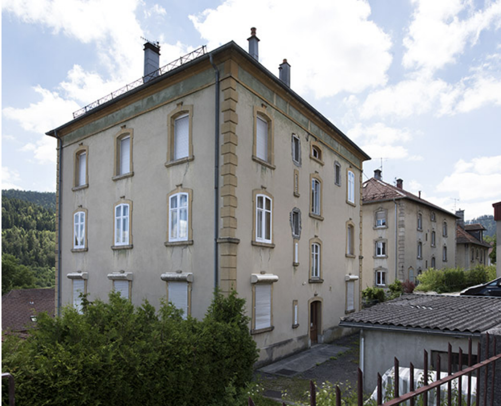
Façades postérieure et latérale droite.
