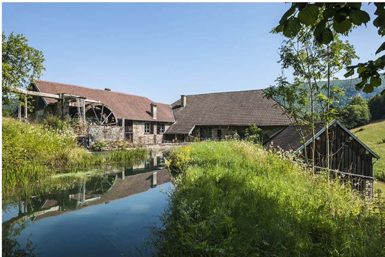
La taillanderie vue depuis le canal d'amenée.
