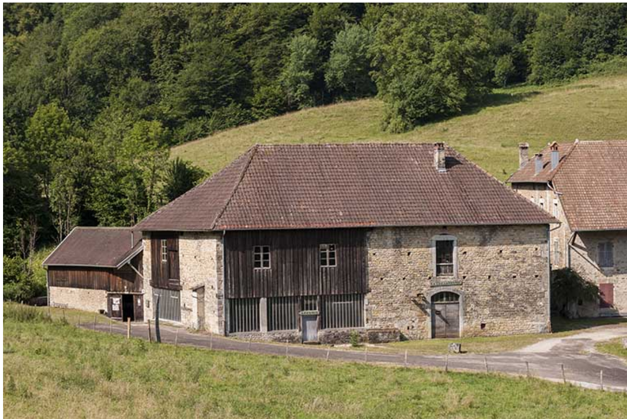
Façade nord de l'atelier de fabrication.
