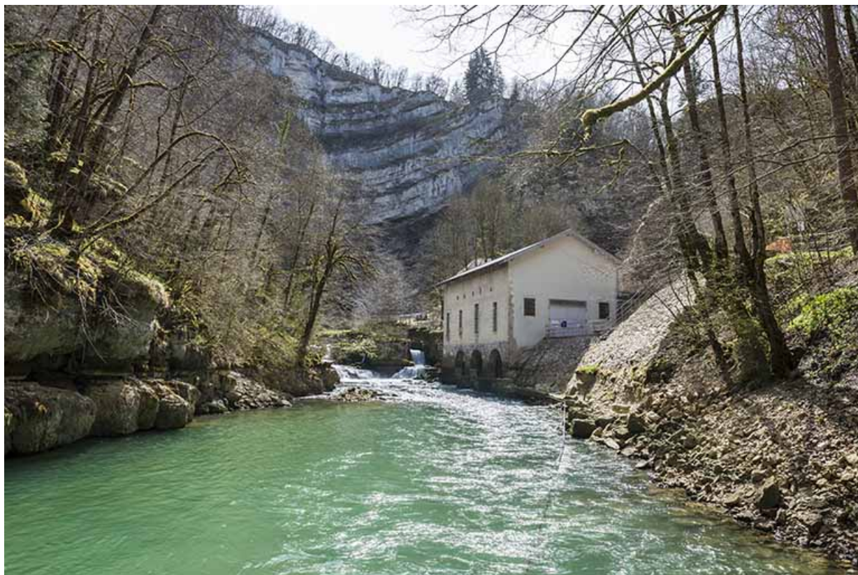
Vue générale depuis l'aval.
