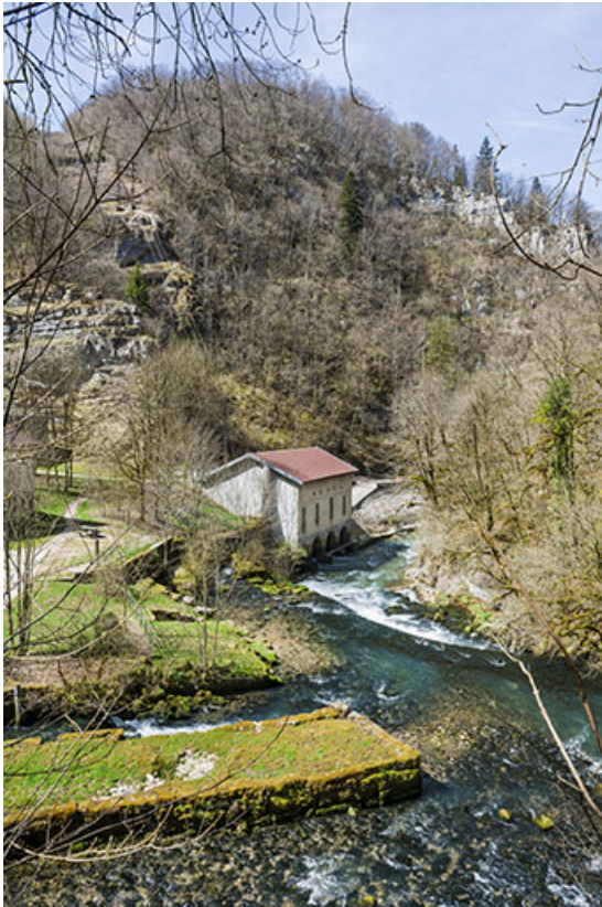
Vue plongeante sur la centrale.
