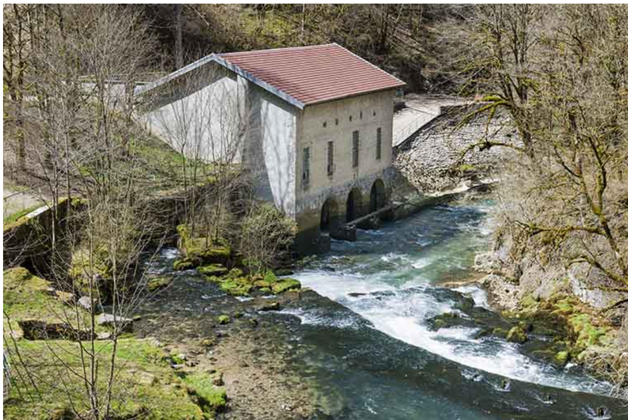
La centrale hydroélectrique depuis l'amont.
