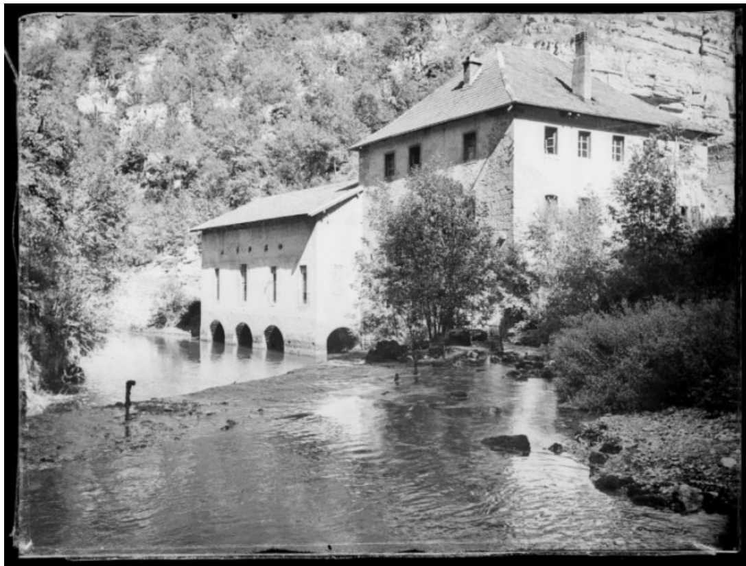
Vue d'ensemble depuis l'aval, fotogr., s.d. [vers 1930].
