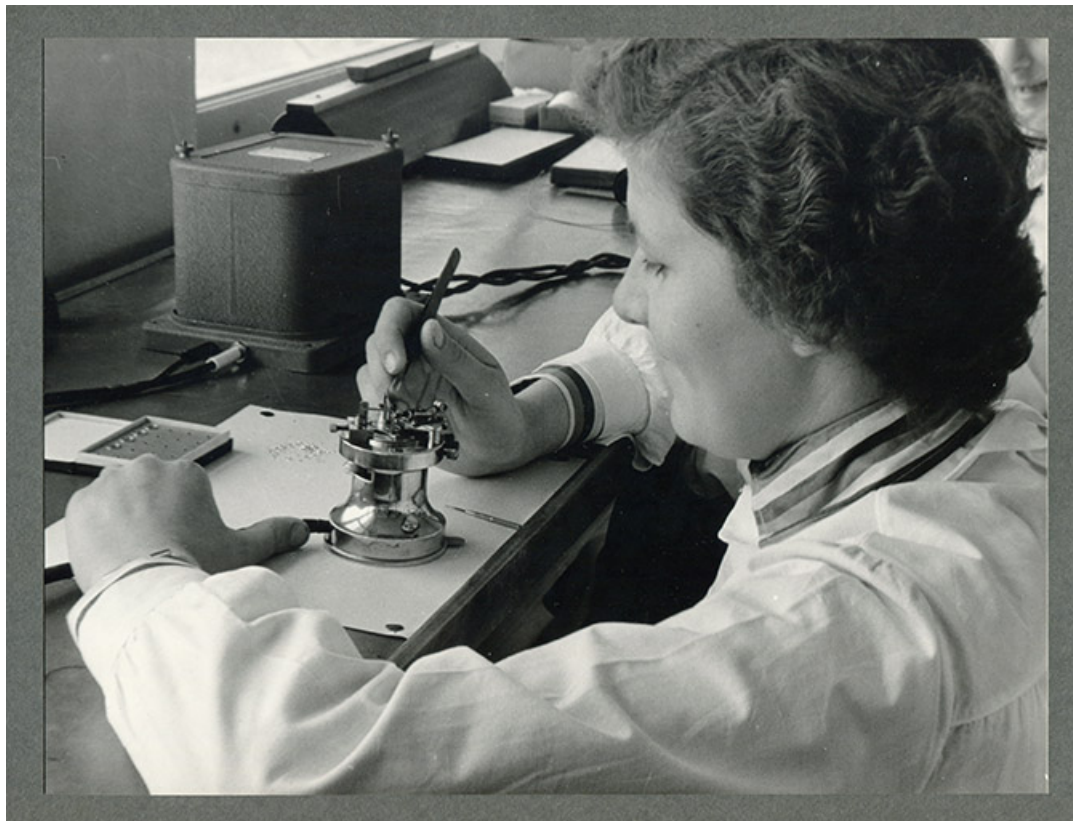
Ouvrière au travail : réglage du balancier-spiral, années 1960.
