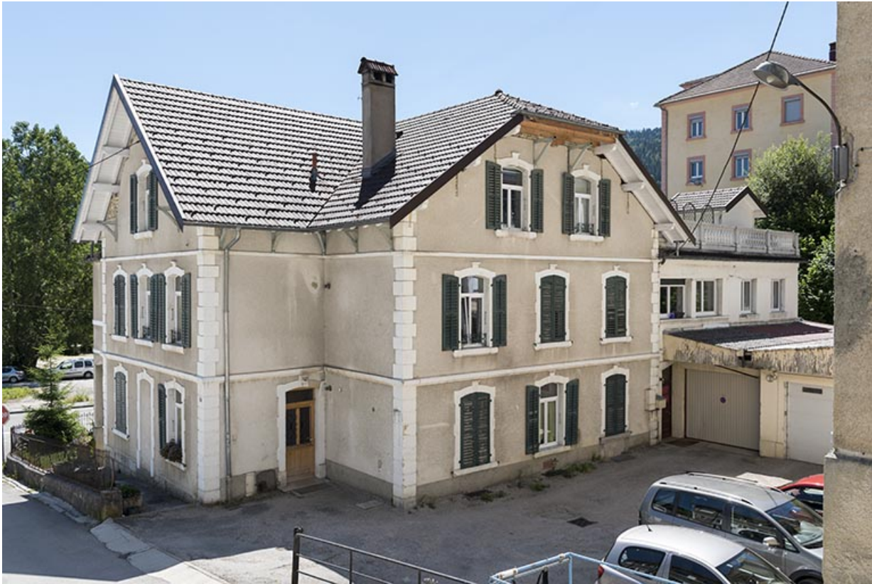
Maison : façades postérieure et latérale droite.
