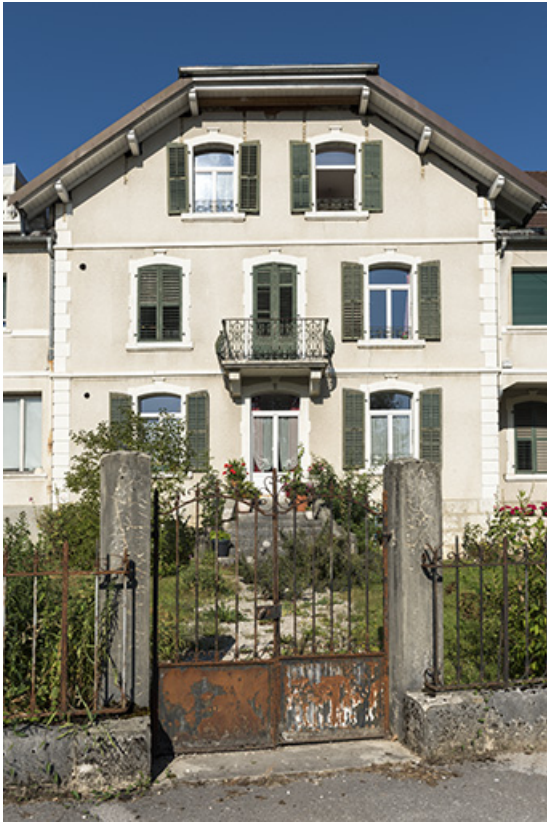
Mason : avant-corps central sur la façade antérieure.
