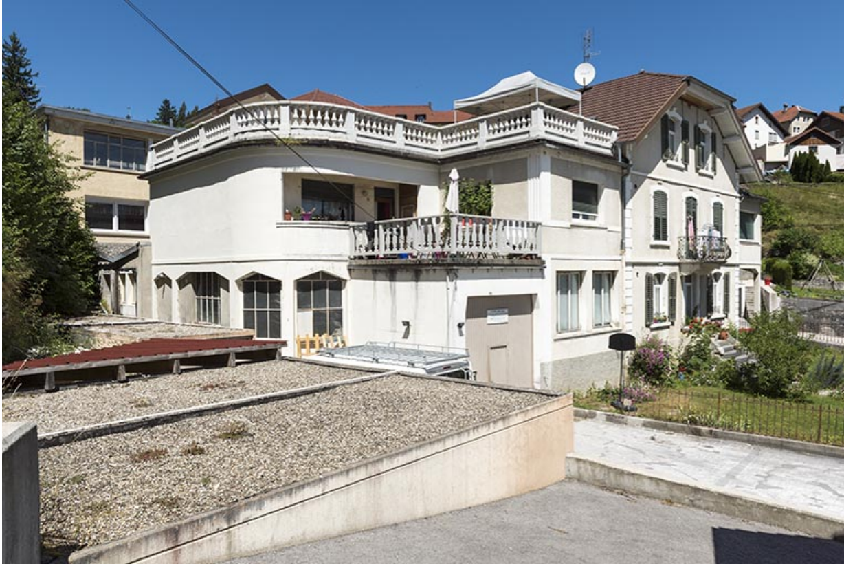
Maison : façades antérieure et latérale gauche.
