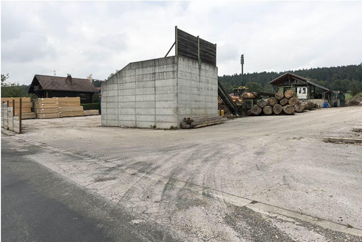
Silo, écorceuse et aire de fabrication.
