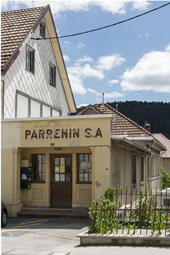
Usine : corps d'entrée, de trois quarts droite.
