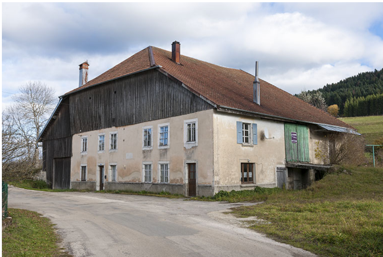
Vue depuis le sud-ouest.
