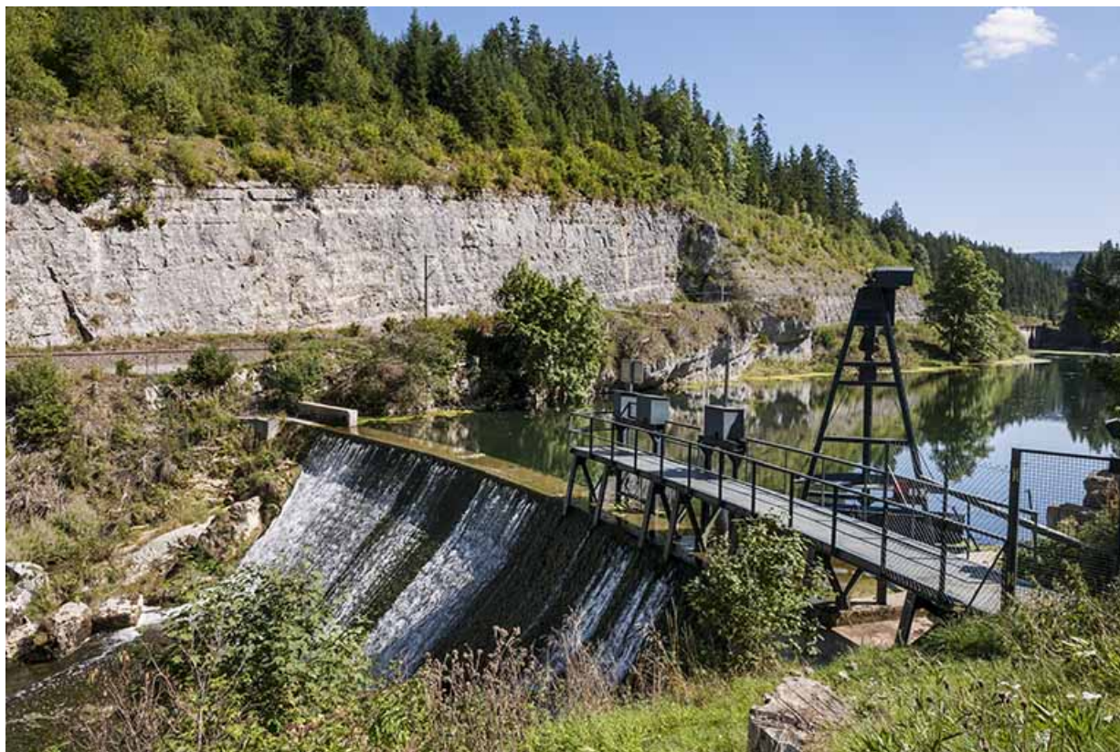
Le barrage depuis la rive gauche.
