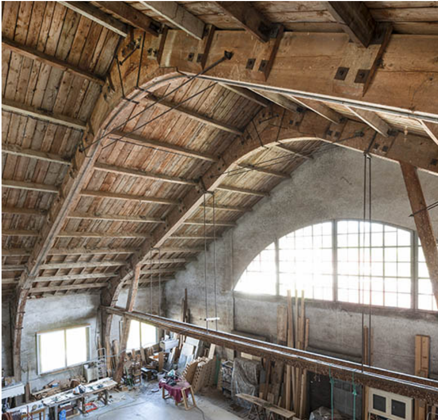
Vue d'ensemble de la charpente.
