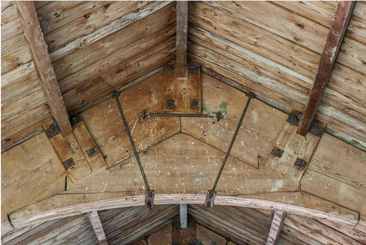
Détail de la jonction d'une ferme.
