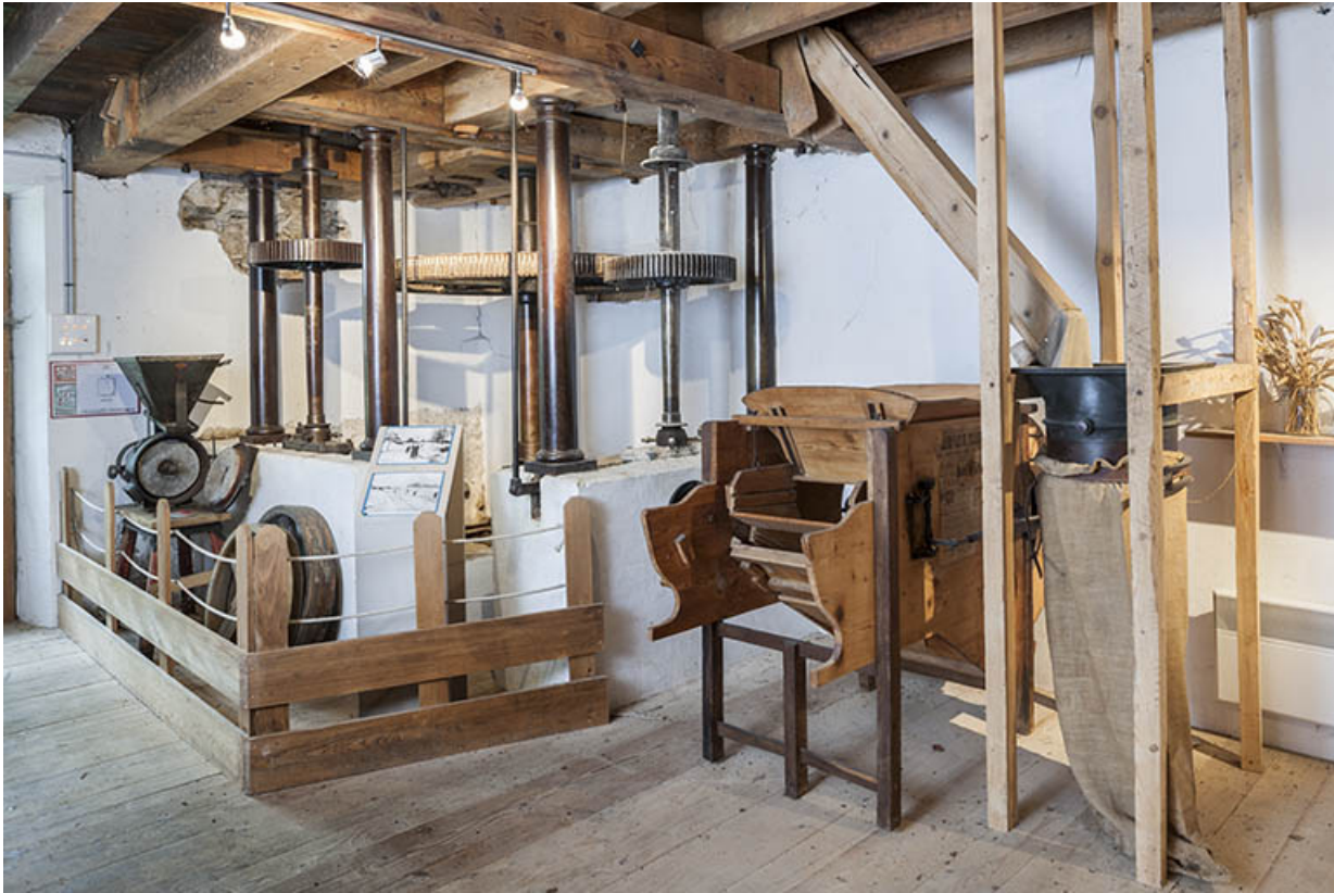
Rez-de-chaussée. Beffroi des meules.
