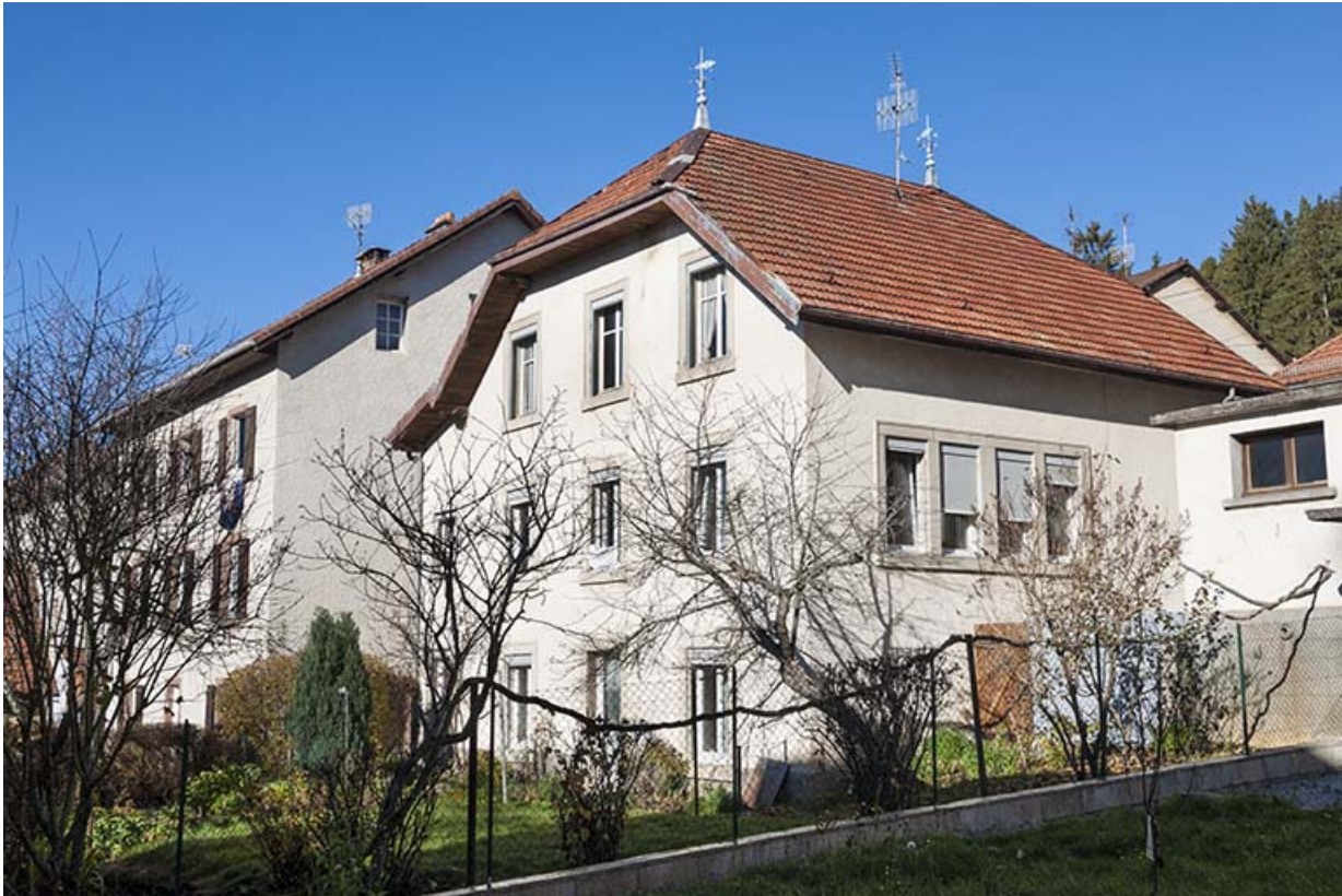
Façades postérieure et latérale gauche.
